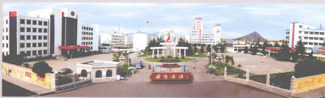
田陈煤矿全景
