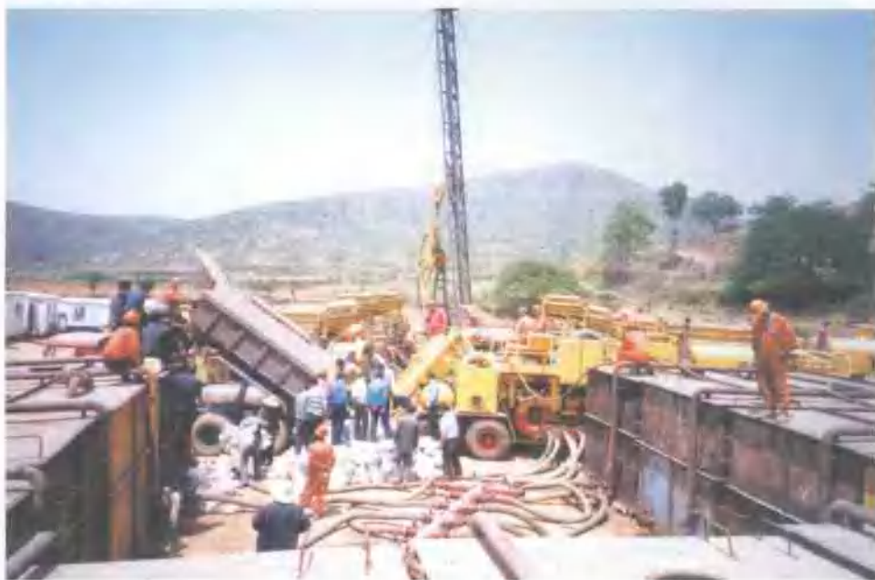
晋城地区煤层气勘探紧张的施工现场
