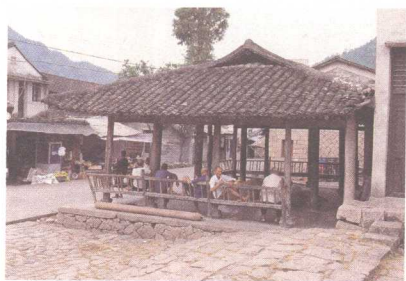
浙江温州楠溪江溪口村路亭
