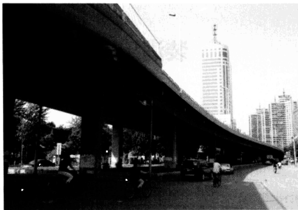
经过改造后的金钢立交桥, 犹如一条巨龙游向美丽的中山路
