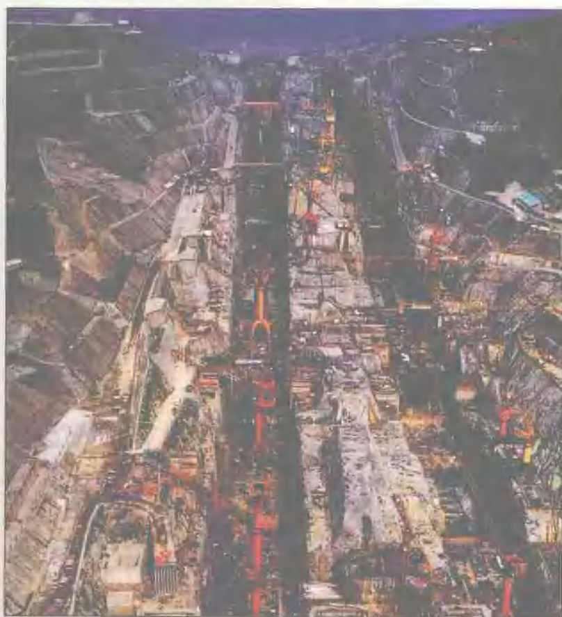
■ 三峡船闸施工现场
