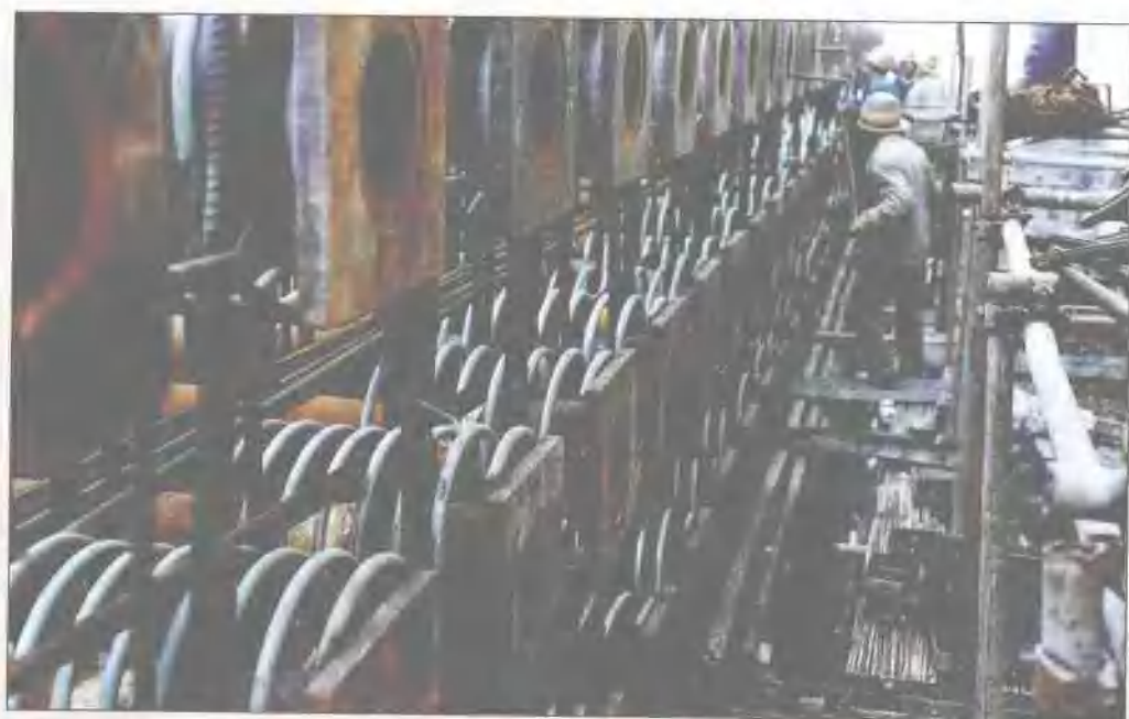
■ 升船机上闸首底板预应力锚索施工
