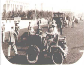
70年代小翻斗车在施工
