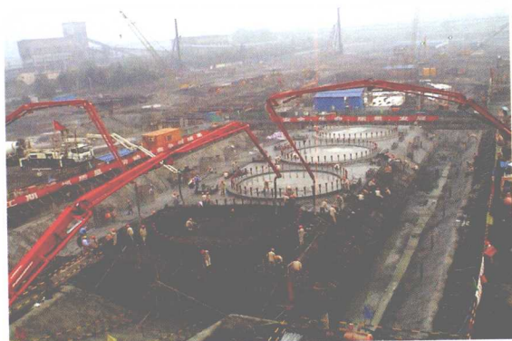
宝钢混凝土浇灌
