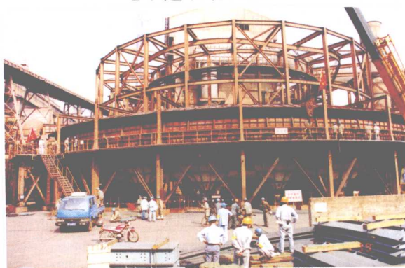
宝钢烧结检修
