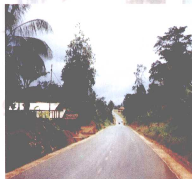
在赤道几内亚建成的道路
