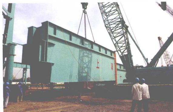
250 吨履带吊在张家港沙钢大型梁吊装
