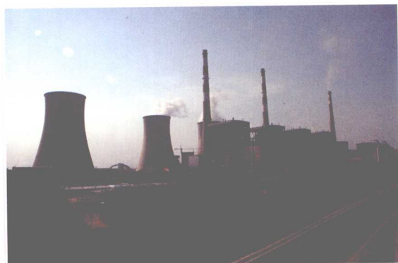
长兴电厂主厂房
