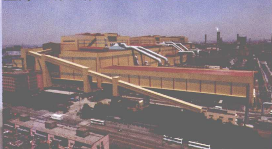
上海一钢不锈钢续建工程全景
