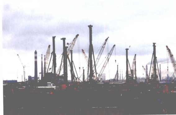
宝钢打桩工地
