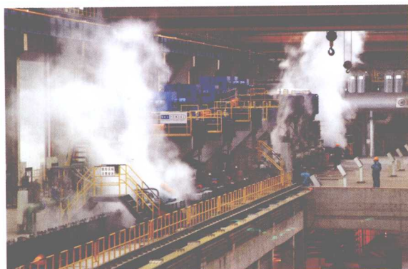
杭钢 80 万吨棒材工程
