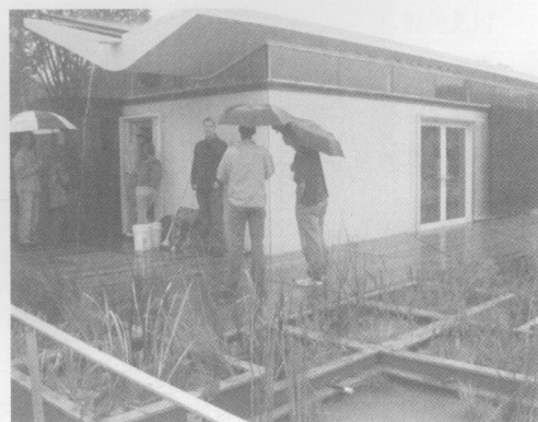
图10 图示景观是入口和生活用水的过滤系统。屋顶排水孔可以收集雨水，创造了一种听觉上的瀑布 (罗伯特·杜奈拍摄)
