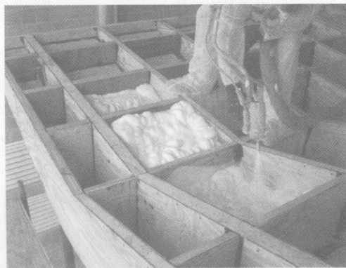
图9 屋顶结构中填充有保温隔热的泡沫绝缘材料 (弗吉尼亚理工大学的太阳能技术竞赛队拍摄)
