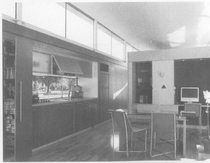
图4 北核心墙内包括用电壁橱、LCD银幕、可拉出的衣柜、可拉出的餐具室、厨房窗户外下的储藏空间、冰箱、用于水槽和加热泵的机械房间、洗衣机/干燥机、折叠的熨衣板以及可拉出的壁橱。沿着墙的秘密管线包括有空调的中央处理记录器(弗吉尼亚理工大学的太阳能技术竞赛队拍摄)
