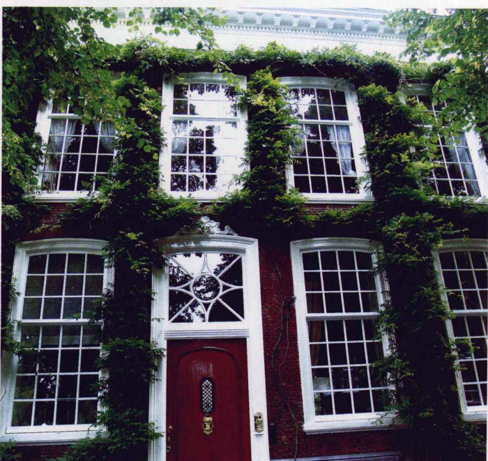
荷兰海牙某住宅墙面绿化
