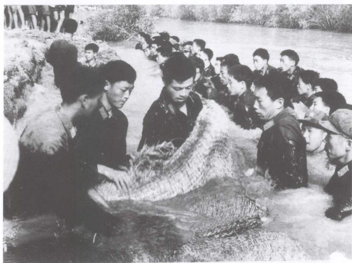
1975年8月，解放军在泉河坎河溜坡堤段用身体和草袋抢险堵口
