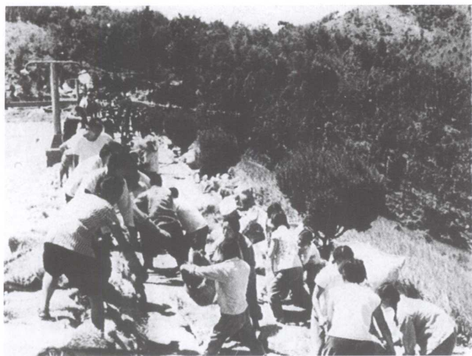
1975年8月，薄山水库职工抢修加固大坝防浪墙
