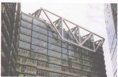
图0-33 索尼中心住宅部分
