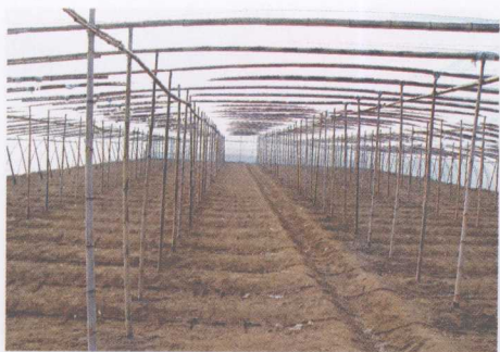
彩图 37 用竹竿、竹片建造的塑料大棚
