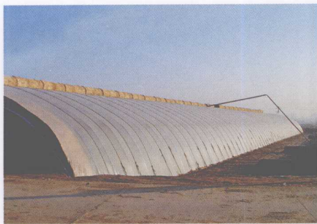
彩图 13 土墙钢筋拱架日光温室及卷帘机
