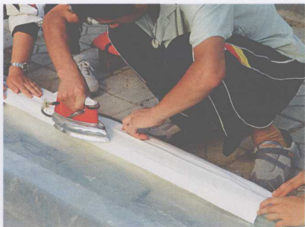
彩图 16 采用热合法粘合聚乙烯薄膜
