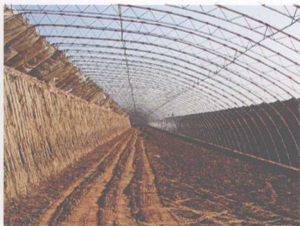
彩图 08 土墙钢筋结构温室构架
