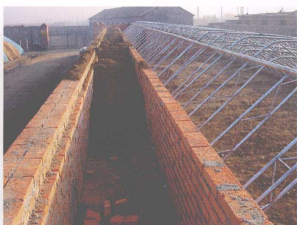
彩图 10 钢拱架温室的砖土复合墙体结构
