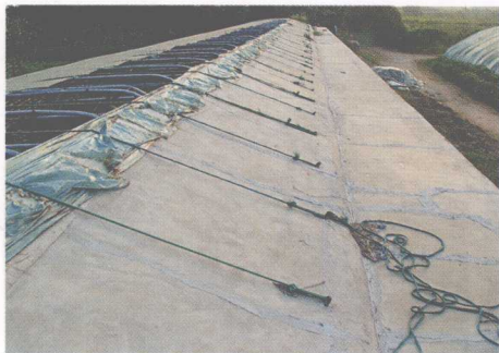
彩图 11 用水泥预制板建造温室后屋面
