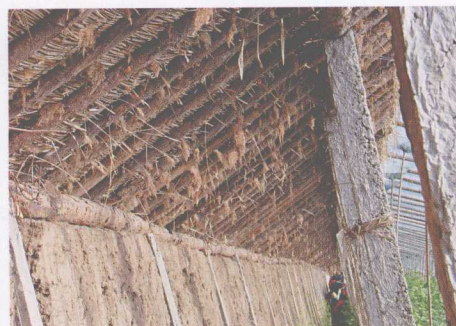
彩图 05 土墙竹木结构温室的后墙及后屋面
