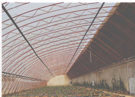
彩图 09 砖墙钢拱架温室结构
