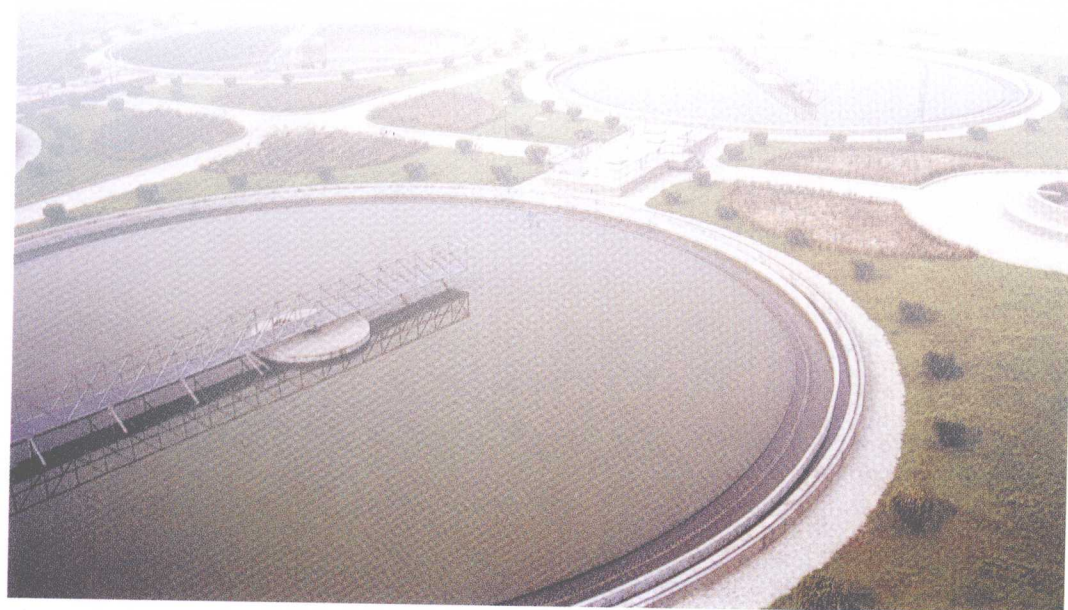
陕西省建成的第一个城市生活污水集中处理厂——西安市北石桥污水净化厂
