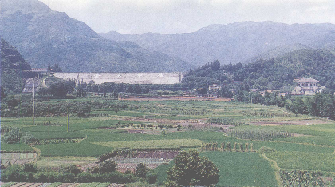
◀ 宁德金涵水库
