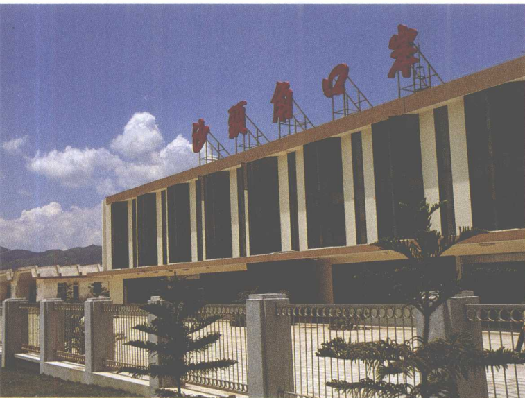
▼ 沙頭角口岸聯檢站一角
