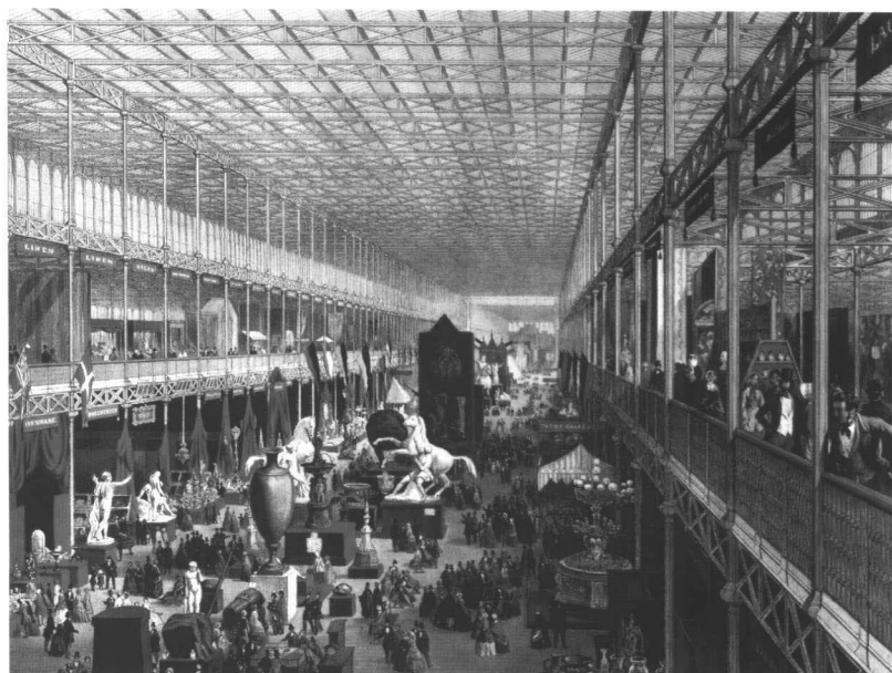
图 1.5、1.6 水晶宫的室内为货品展示提供了前所未有的大空间，它的钢架玻璃结构还提供了良好的采光。
