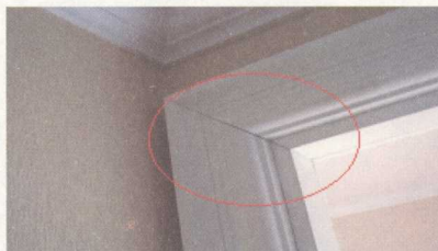
图4 门套开裂
