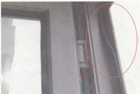
图2 密封胶条脱落密封不严， 保温隔声受影响
