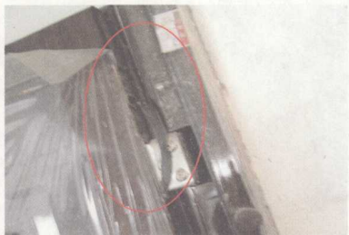
图6 防盗门胶条脱落影响 保温隔声效果
