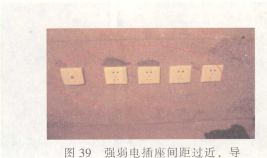
图 39 强弱电插座间距过近，导致弱电信号受影响
