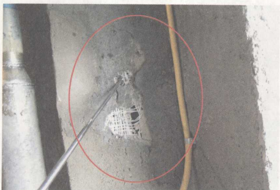
图 48 排烟道破损
