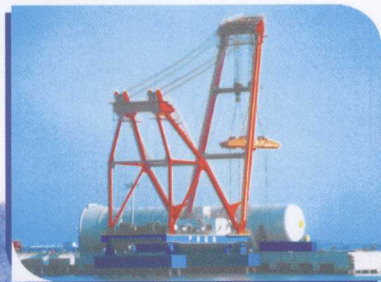
上海化学工业园大件码头600T固定吊电系统设计制造及调试
