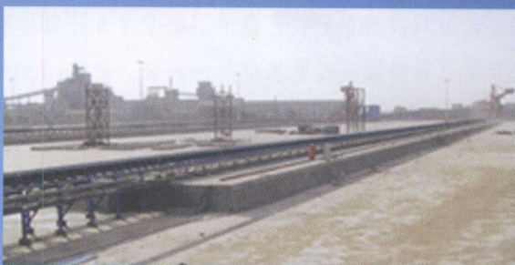
湛江矿石码头扩建工程皮带机
