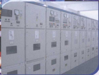
连云港港口集团有限公司东联港务分公司变电所改造工程
