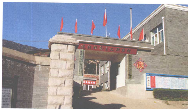
改造后的车耳村村委会办公楼
