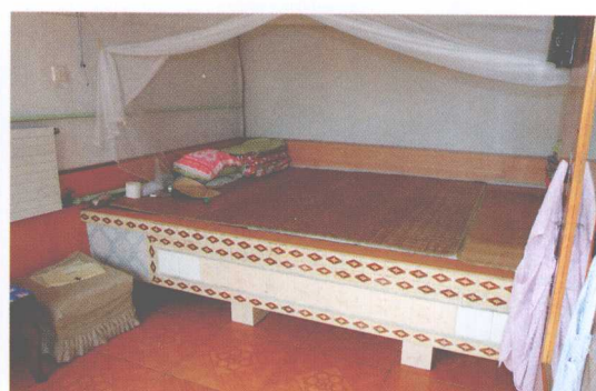
大兴区安定镇农户安装高效节能卫生吊炕
