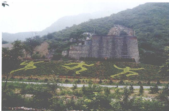
门头沟区生态修复示范工程进展顺利
