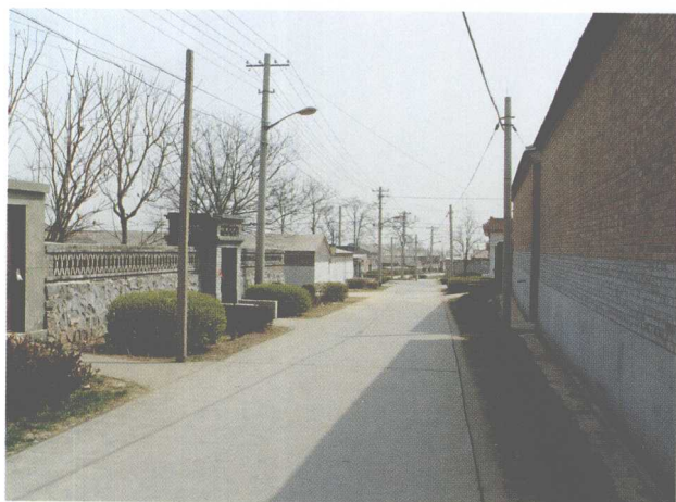
村巷路面硬化
