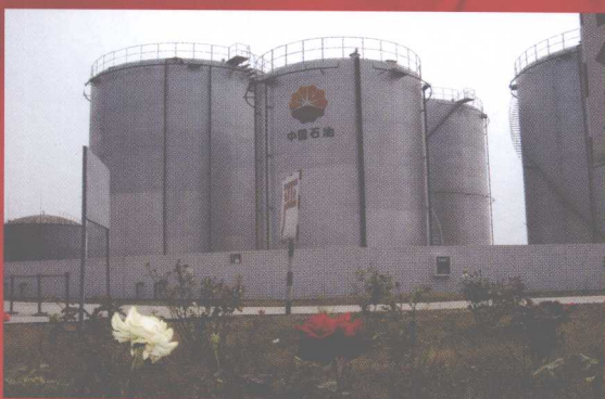
二次到达库高耸的油罐群
