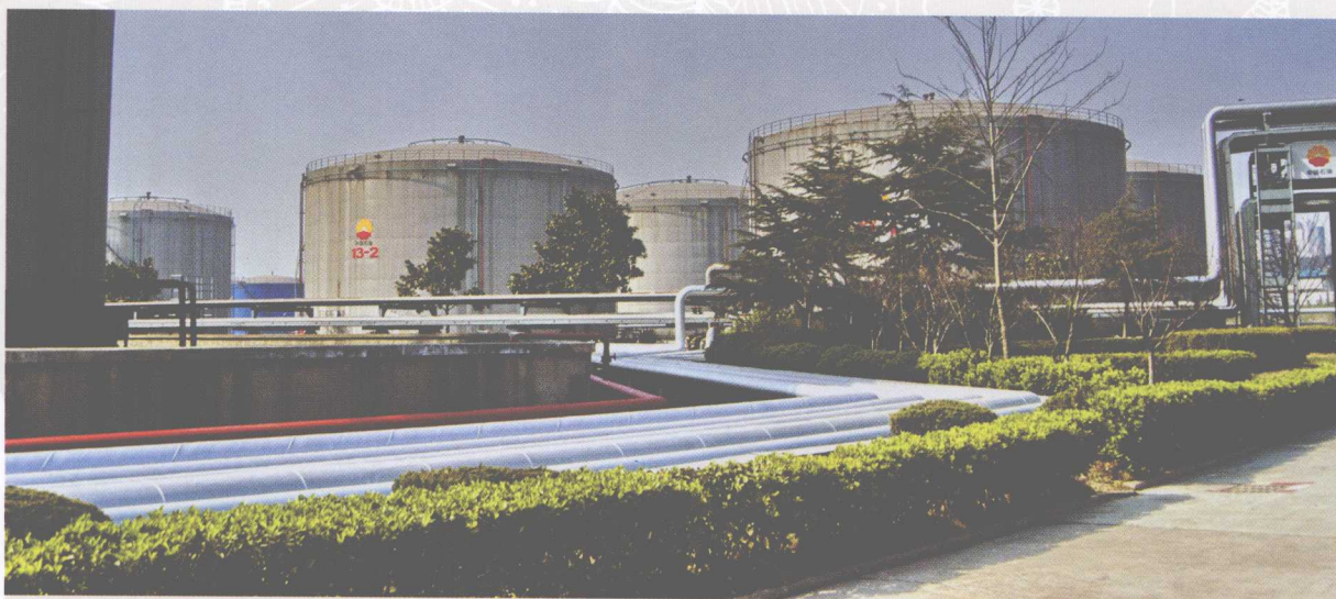
花园式油罐群区
