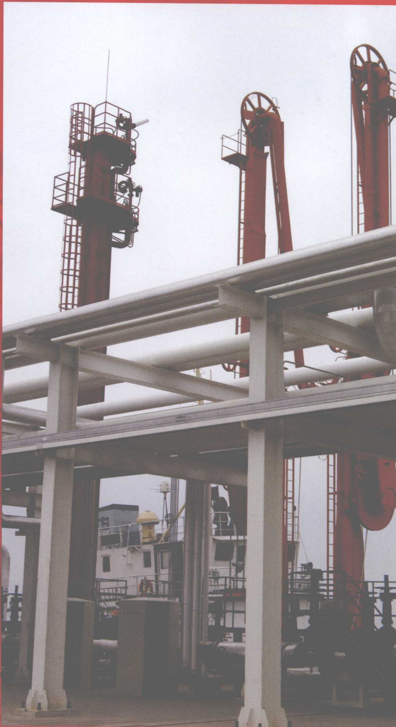
高耸的装卸油装置正在按程序紧张地进行作业
