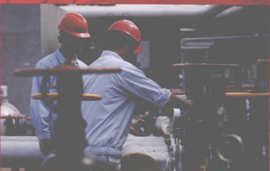
油库员工正在娴熟地操作卸油设备
