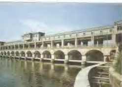
新三江闸水利工程。
