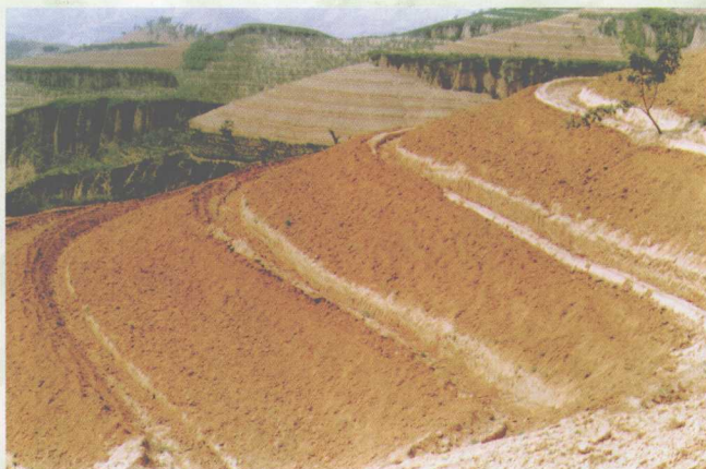
黄土高原修建的 隔坡水平沟
