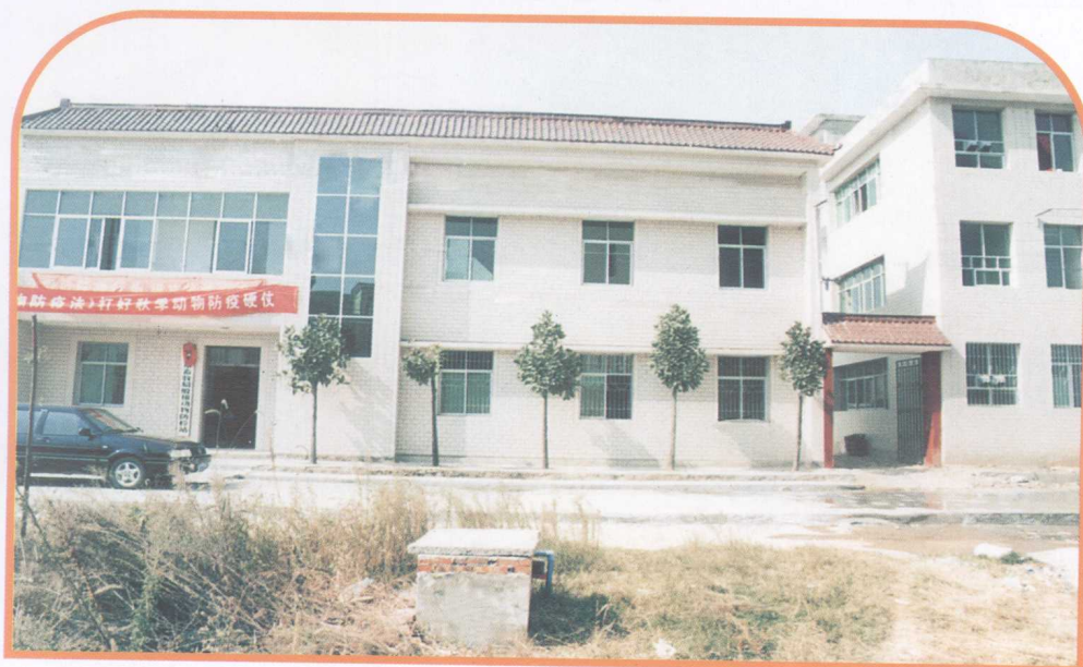
殷祖防检站办公及宿舍楼
