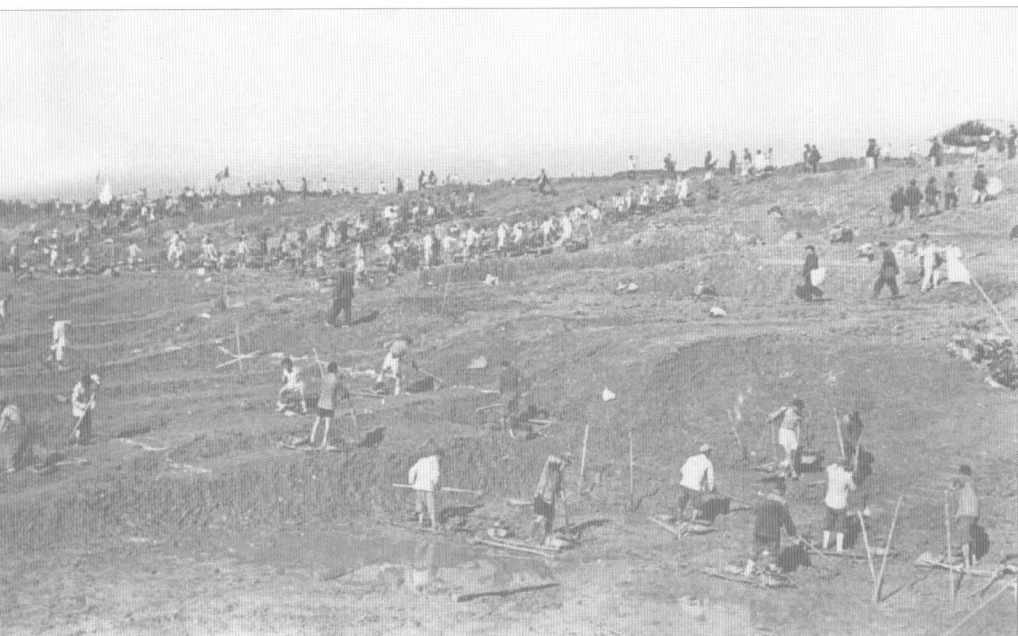
京杭运河无锡段无锡县民工团施工工地(1956年4月)
