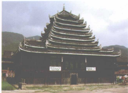
通道马田鼓楼 位于通道侗族自治县坪阳乡田心寨境内，马田鼓楼无一钉一铆，八柱檐柱直至第一檐，给人以擎天之感。
