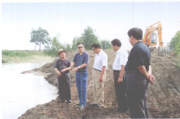
自治区水利厅总工程师薛塞光(左一)在唐徕渠工地检查工作
