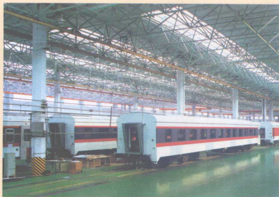
四方客车分 厂总装配车间（网 架结构）
