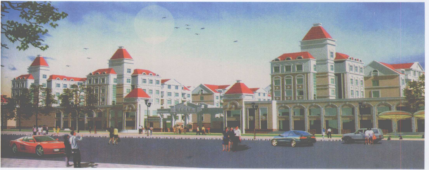
山东东营工益花园住区
