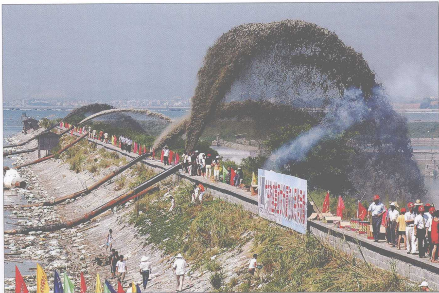
7月22日，厦门环东海域综合整治建设首期工程开工。图为清淤吹填施工现场。（陈立新 摄）
