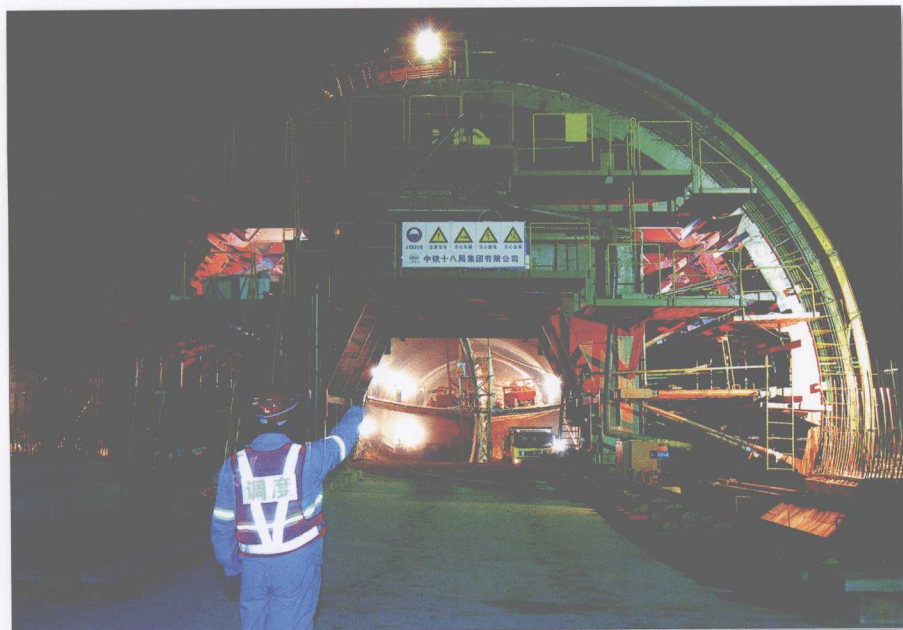
翔安隧道施工现场（李鸾汉 摄）
