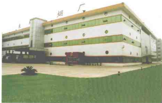
■ 来凤卷烟厂主厂房，1985年完成主体工程，经两次扩建，建筑面积达22635平方米
