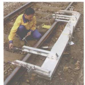
钢轨对正架梁
