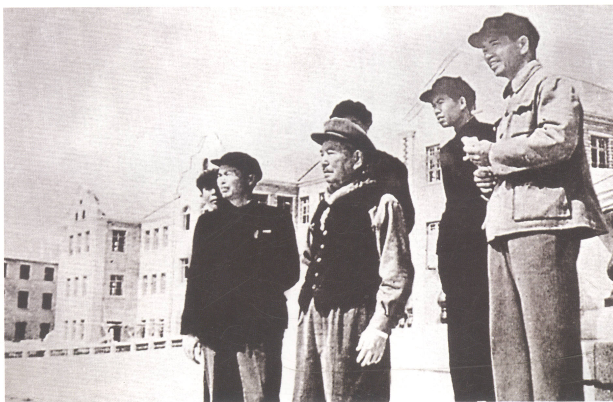
二十世纪五十年代初，陈嘉庚（前排左二）视察厦门大学建南楼群建设工地
