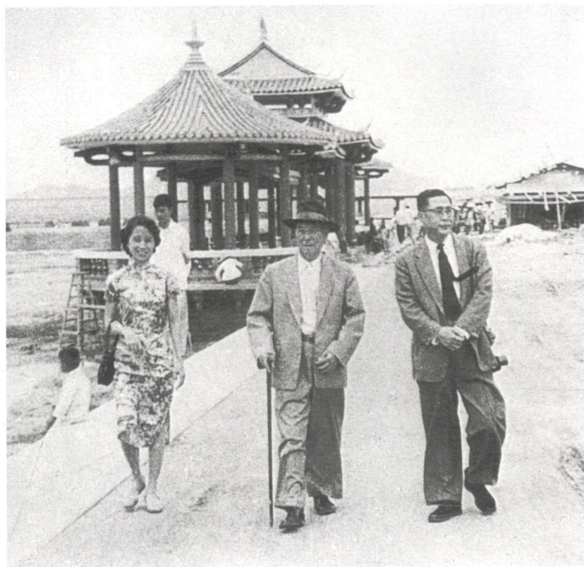
陈嘉庚巡视集美美学村建设工地
