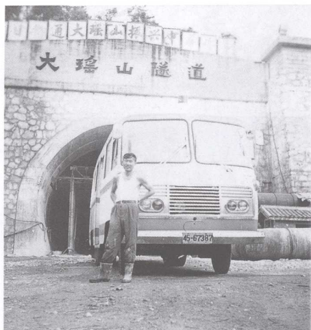
1981年在大瑶山隧道出口进行全工艺试验
