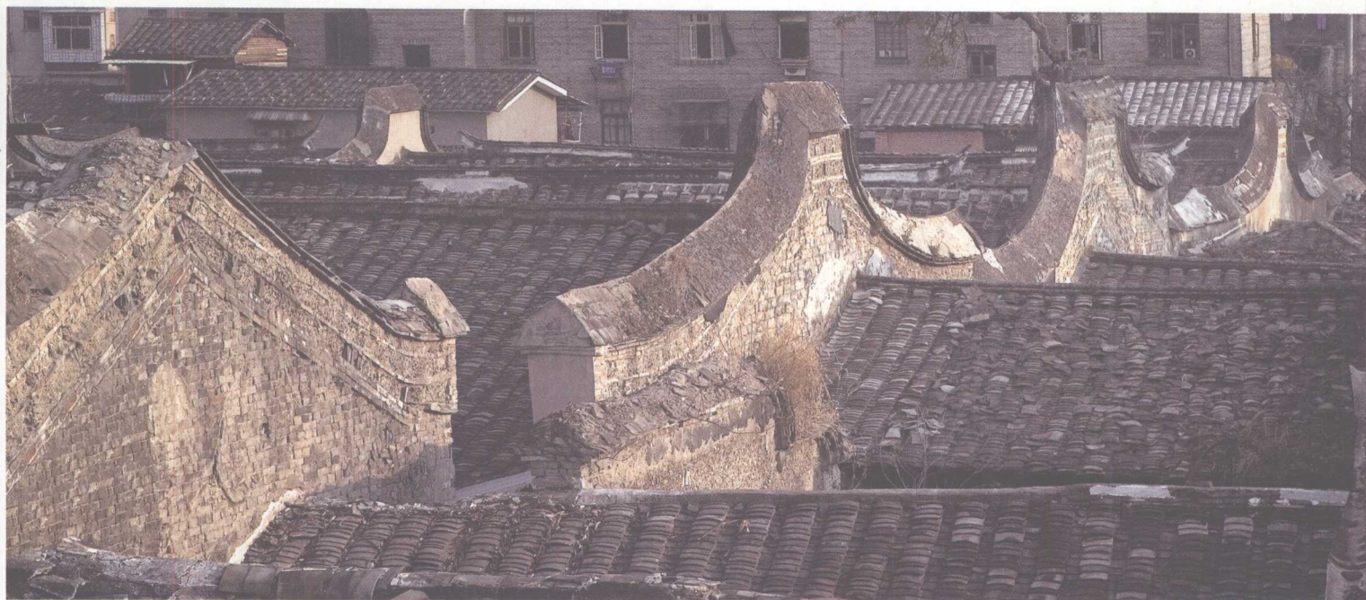
连接安民巷和宫巷房屋间的马头墙
