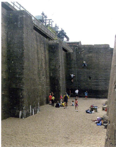
图20 杜伊斯堡北风景公园混凝土墙体改造为攀岩训练场
