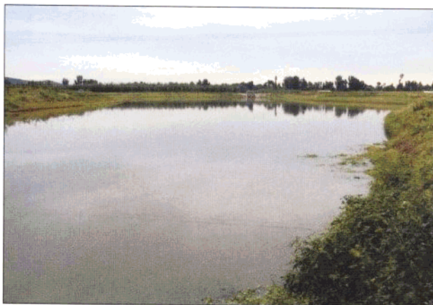
龙湾屯双源湖集雨工程
