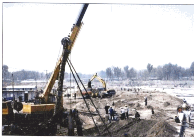
橡胶坝施工现场
