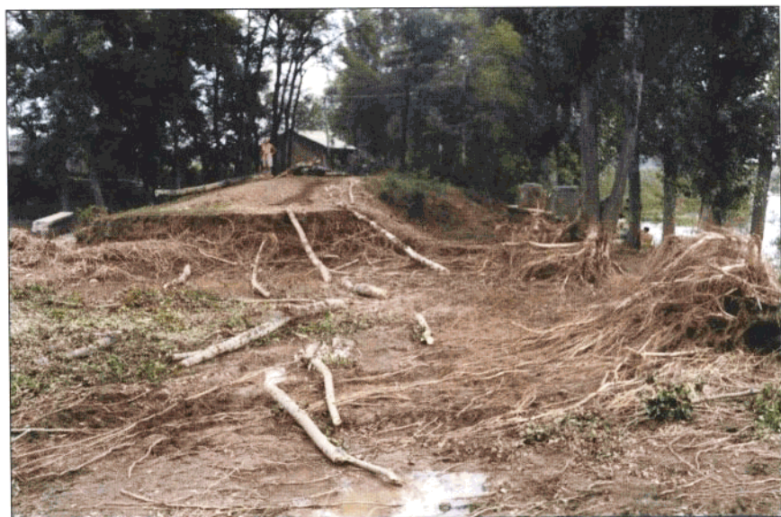
1994年7月12日洪水冲毁箭杆河汉石桥水库大坝
