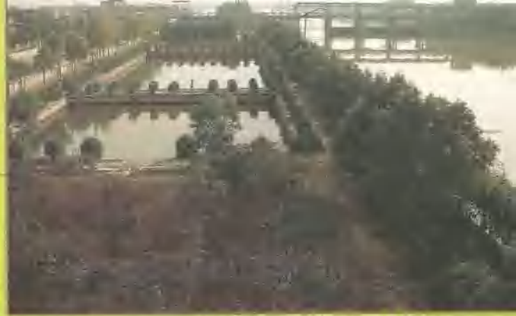
刘港港水闸为上海最大的水利工程。
