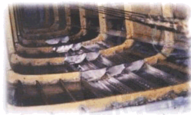
彩图⑫ 机身内下壁、框缘、长桁腐蚀严重处补一块不锈钢板
