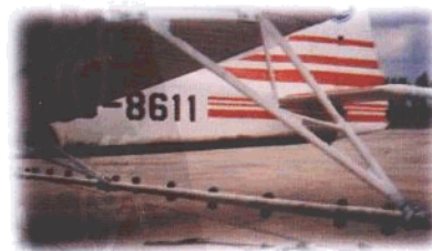
彩图⑯ 喷液管腐蚀严重
