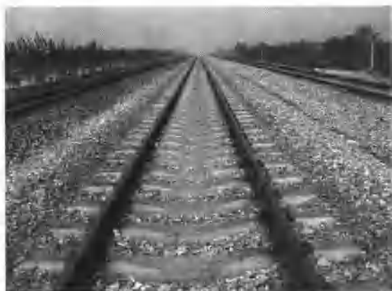
图1—1—1 CHN60型钢轨、混凝土枕无缝线路
