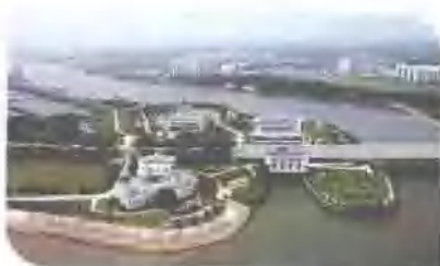
▲顺德区桂畔海水利枢纽工程
