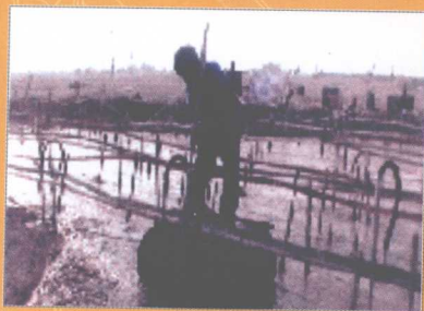
一、插电渗水井点管本工法处理流塑状淤泥质土在无法上人的场地进行插管施工
