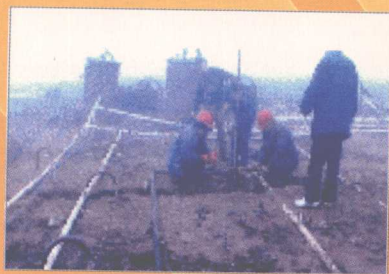
四、拔出电渗井点管 (保留外围管)
