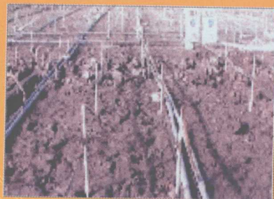
二、经电渗降水 20 天后场地阳极管周围明显产生干裂缝, 场地白
