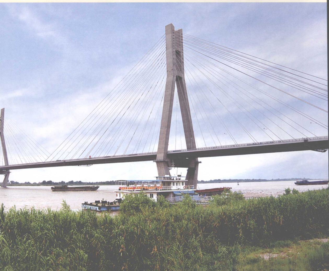
润扬长江公路大桥
