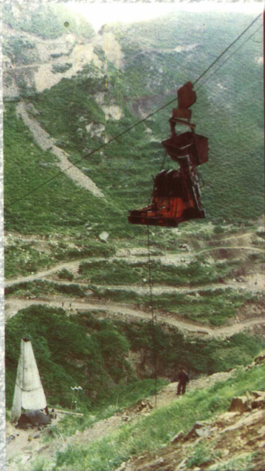
支家地银矿区勘探中利用空中索道搬运钻机
