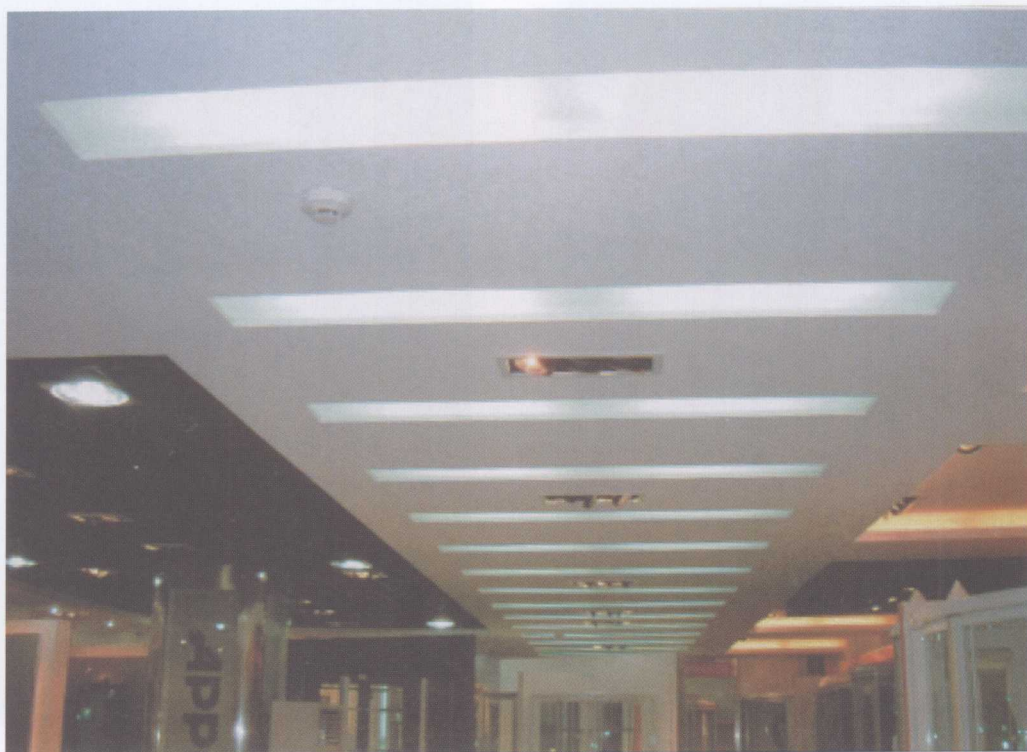
石膏板采光吊顶
