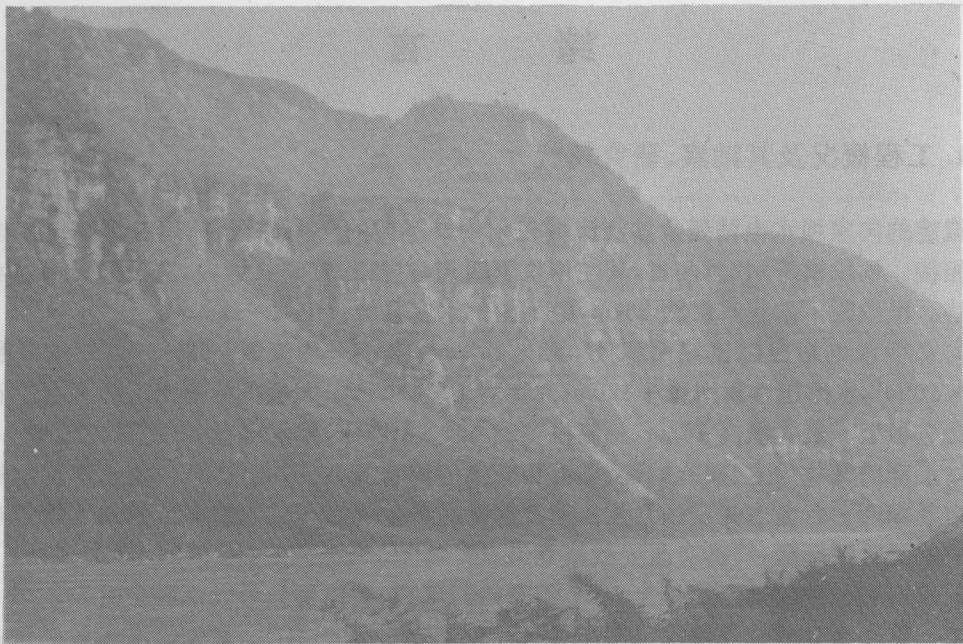
照片1 马步坎高边坡全景
