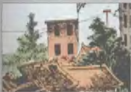
7~8度:房屋破坏,地面裂缝
