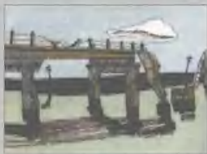
9~10度:桥梁、水坝破坏,房屋倒塌,地面破坏严重
