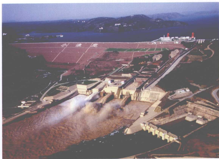
小浪底水利枢纽航拍全貌（梁君 摄）
