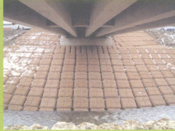
⑦ 铺完棕榈石后，在上面覆上一层施工时挖出的泥土，完成所有的工程
