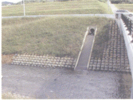
2002年5月使用原有的混凝土砖块在岸边施工的情形。施工时期与棕榈石基本相同，岸边的覆盖土被流水冲失
