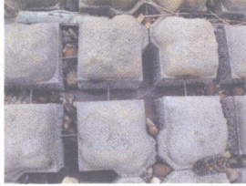
混凝土砖块的表面状况。几乎没有植物生长
