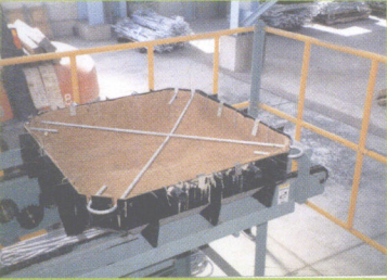
① 铺有椰子纤维薄层的模具。把混凝土注入其中，形成混凝土砖块
