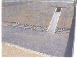
2002年10月使用原有的混凝土砖块在岸边施工的情形。在覆盖土流失的地方，几乎看不到有植物生长
