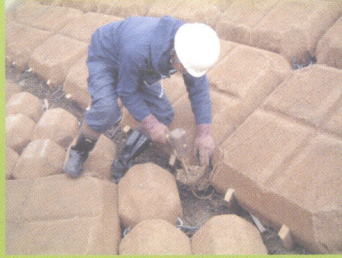
③ 铺设棕榈石，再在石块间栽上植物
