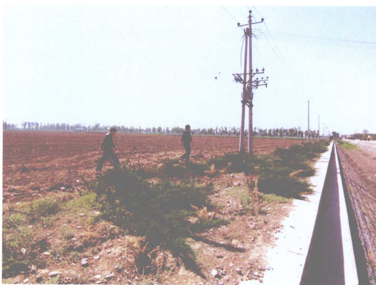
照片3 结合小城镇建设建成的农田排灌和电力系统景观图
