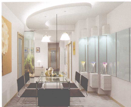
石膏板造型吊顶
