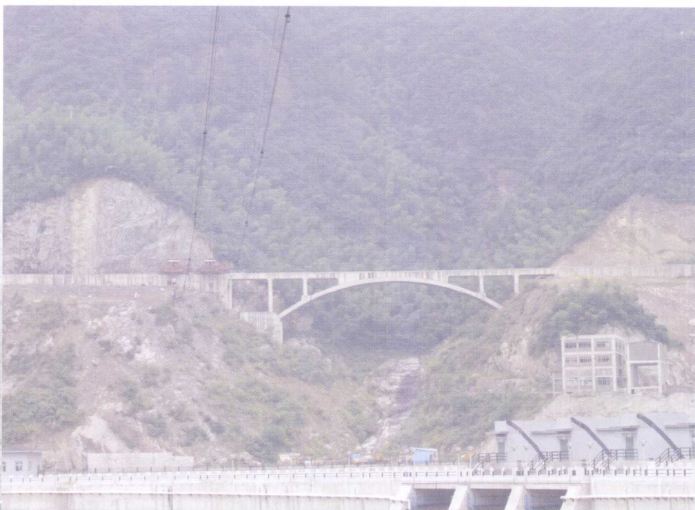
图17 20t缆机移动端拱桥
