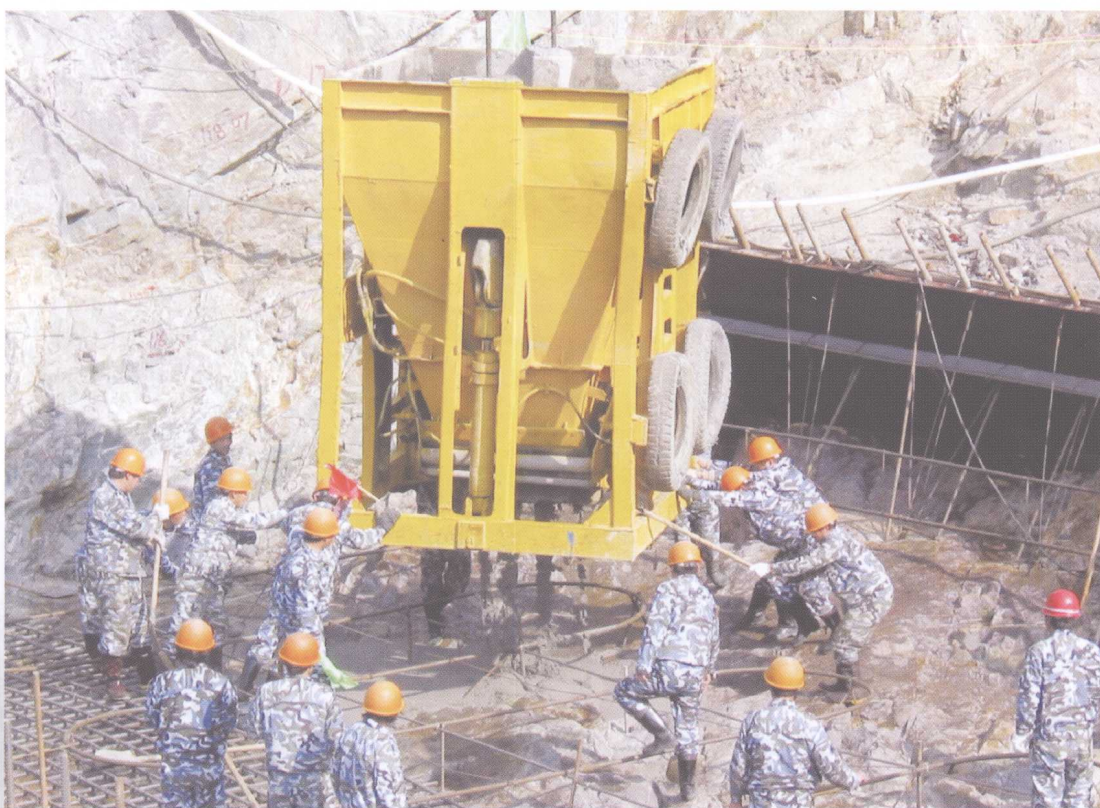
图15 2003年2月18日开工 同年12月6日浇筑坝基第一仓混凝土
