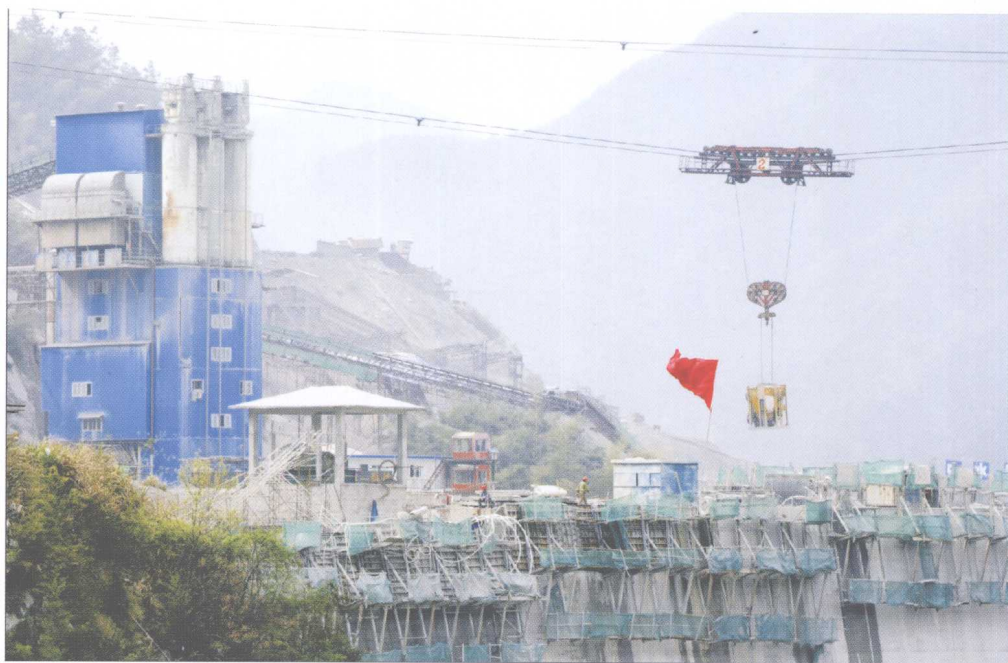
图16 20t缆机将混凝土入仓
