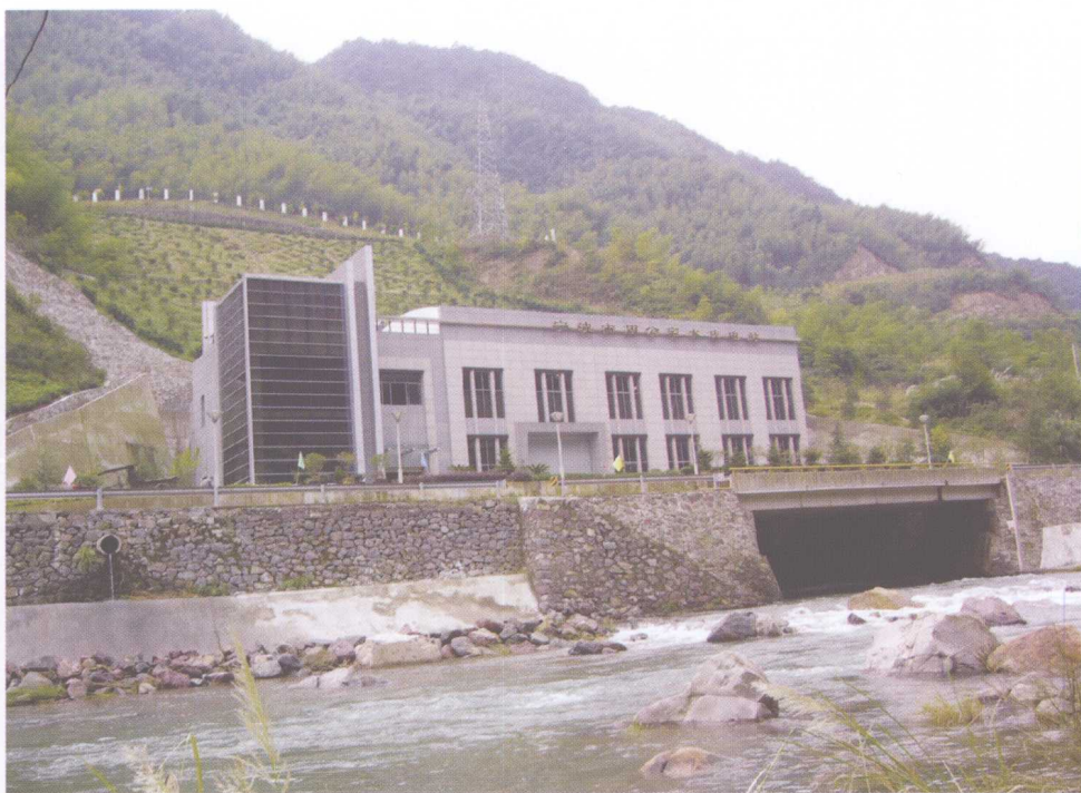
图4 发电厂房外景
