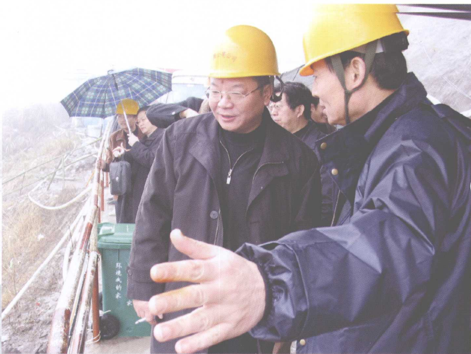
图19 副市长陈炳水（左）来工地检查工程
