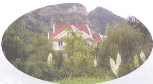
图12 中水四局项目部办公楼
