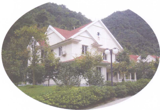
图10 工程监理部办公楼
